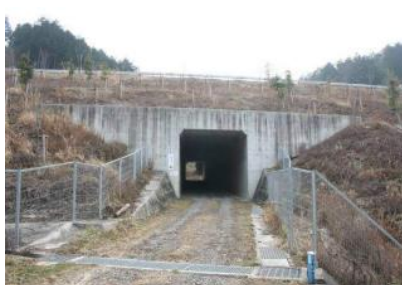
Figura 106 Paso de fauna inferior para mamíferos de tamaño mediano y grande en el este de Japón. (Sonoda, Asari, & Minato, 2022).
