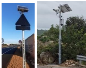
Figura 12. Señalización dinámica inteligente: detección mediante infrarrojos. (Diputació de Tarragona)
