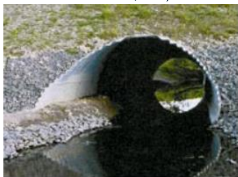
Figura 155. Obras de drenaje adaptado. (Vägverket. Banverket, 2005).
