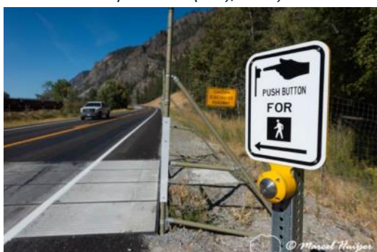
Figura 78. Botón pulsador que activa el temporizador (apaga la electricidad durante 1 minuto) para peatones en un paso electrificado MT Hwy 200, Thompson Falls, Montana, EE. UU. (Nevada Department of Transportation (TPF), 2020).
