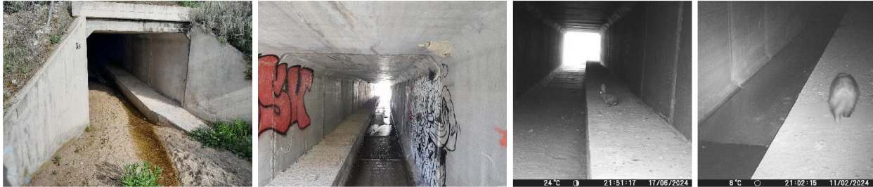
Figura 63 Obras de drenaje transversal adaptadas. (Comunidad de Madrid).
