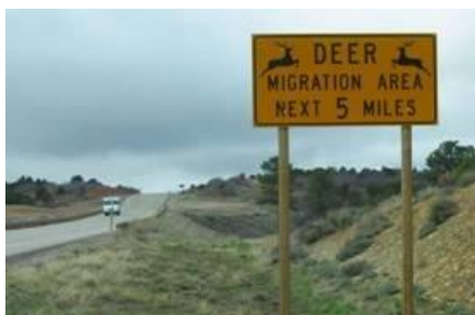
Figura 67. Panel de aviso de zona área de migración de fauna (copyright: Marcel Huijser). (Federal Highway Administration (FHWA), 2008).
