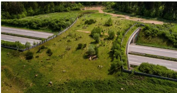
Figura 114. Paso superior de fauna y vallado cinagético de Kiebitzholm, cerca de Bad Segeberg. Foto de : Servicio de fotografía aérea Bernot. (Süddeutsche Zeitung Magazine. Von Roland Schulz, 2018).
