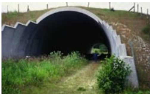
Figura 154. Paso inferior de fauna. Suecia. (Vägverket. Banverket, 2005).
