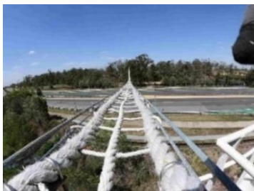
Figura 90. Cruce de cuerda plano. Australia (Fauna Crossing).
