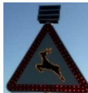
Figura 8. Señal P-24 reforzada con luces LED. (Diputación de Soria)
