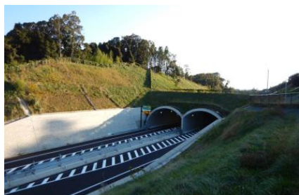
Figura 105. Paso de fauna superior para mamíferos de tamaño mediano en el este de Japón. (Sonoda, Asari, & Minato, 2022).
