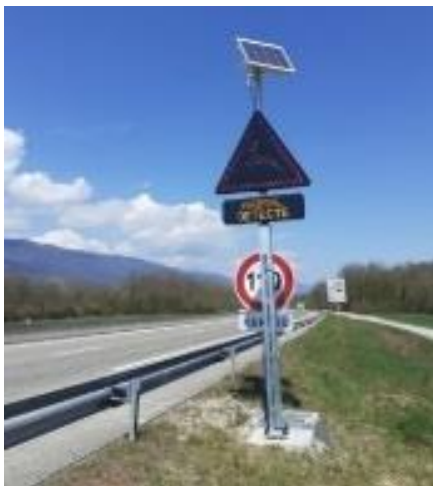
Figura 137. dispositivo de advertencia que se activa cuando se detecta vida silvestre © Departamentos de Ain (Patrimoine(s) de L'Ain, s.f.).
