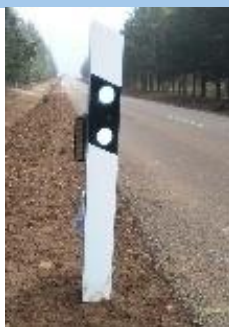
Figura 34. Disuasor ultrasónico. Instalado en carretera. (Diputación de Badajoz).
