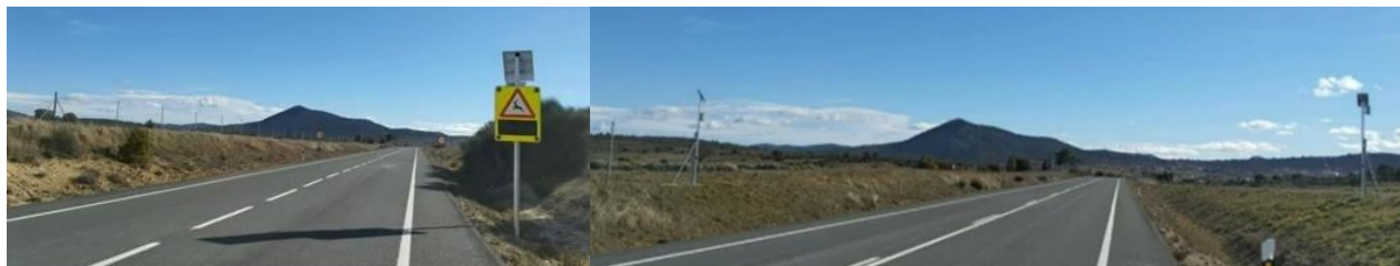
Figura 65. Sistema de advertencia y canalización de animales en la calzada. Pasos de fauna a nivel. (Junta de Castilla y León).
