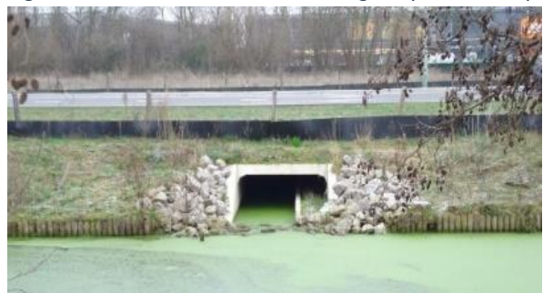
Figura 121. Obra de drenaje adaptada. Bélgica. (Van der Liden Beton bv).
