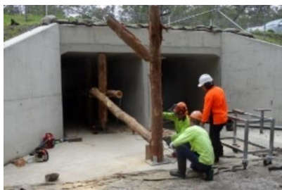
Figura 93. Obra de drenaje adaptada para el paso de koalas. Australia. (Fauna Crossings).
